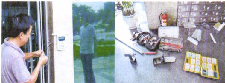
大樓內、外監視系統整合、裝設工程
